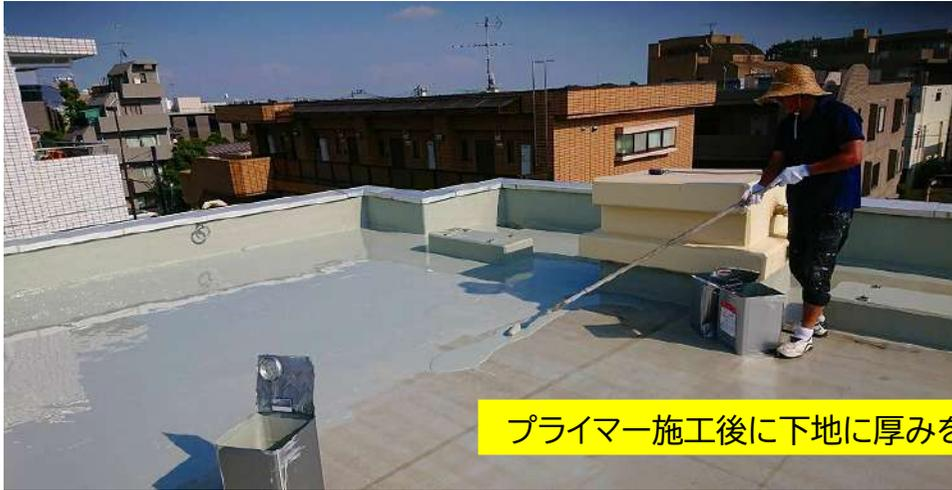
プライマー施工後に下地に厚みを付けるためのウレタン材を塗布
