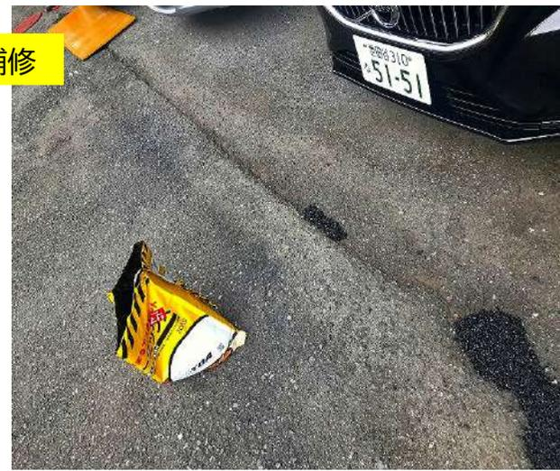
最後にアスファルト専用塗料で黒く色を付けていきます
