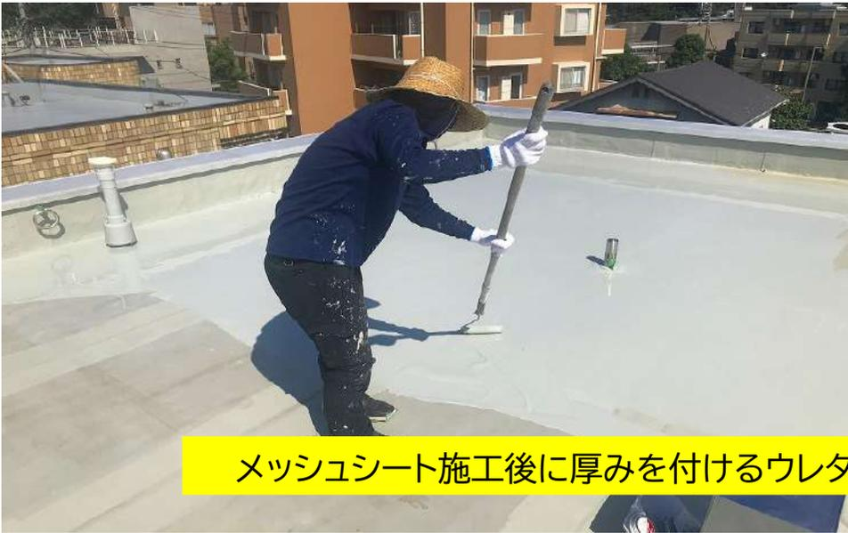
メッシュシート施工後に厚みを付けるウレタン材を2回塗る事により強度が増します。
