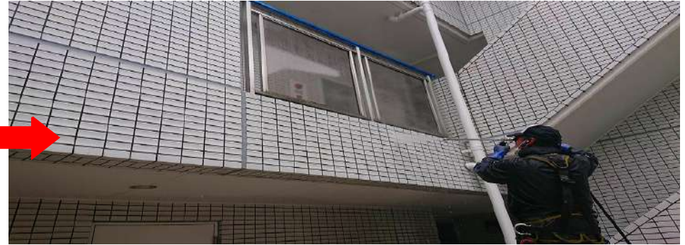
外壁タイルの洗浄施工の様子
