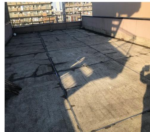
目地材の浮きやコンクリートのクラック、コンクリート状態は放置せず防水施工を!
