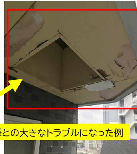
コンクリートのまま放置しクラックが発生、後に下の階の天井と部屋内へ漏水した結果、入居者様との大きなトラブルになった例
