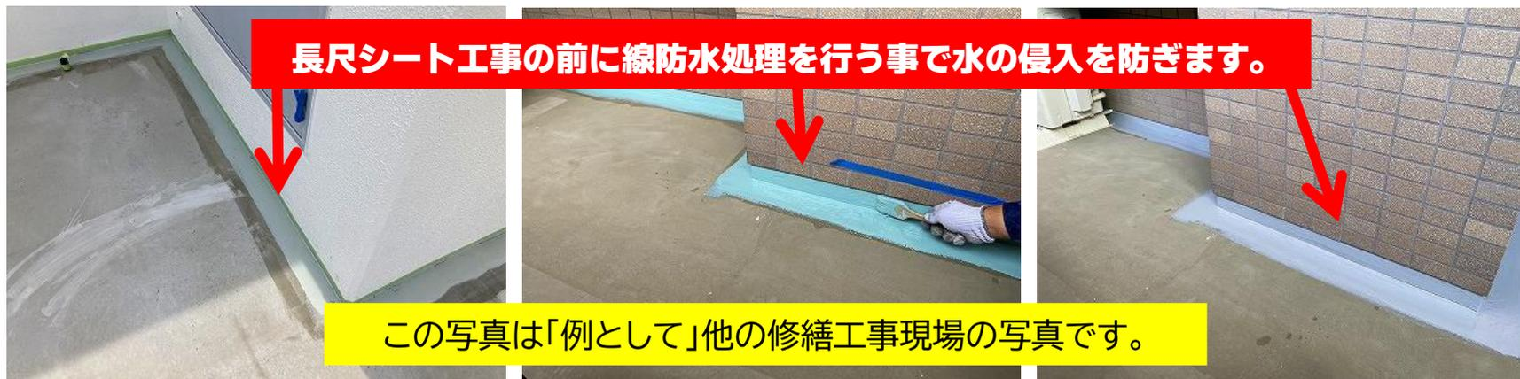
長尺シート工事の前に線防水処理を行う事で水の侵入を防ぎます。
