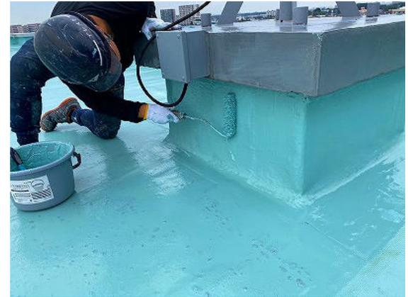
高反射トップコート材塗布(平場・架台部・立上り部)
