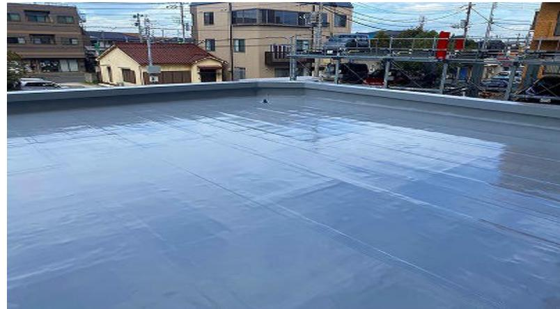
プライマー塗布→改修ドレン新規設置→シート継ぎ目メッシュ敷き→ウレタン材塗布→保護トップコート塗布仕上げ
