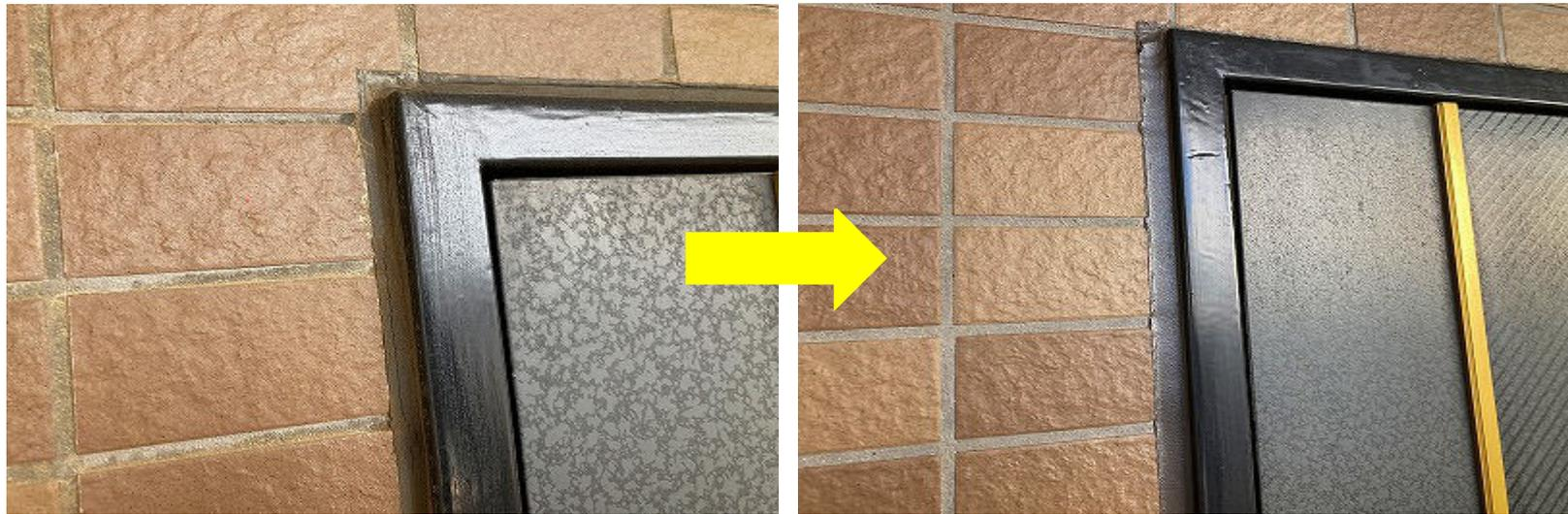
旧シーリング撤去 → プライマー塗布 → シーリング打ち込み馴染らし
